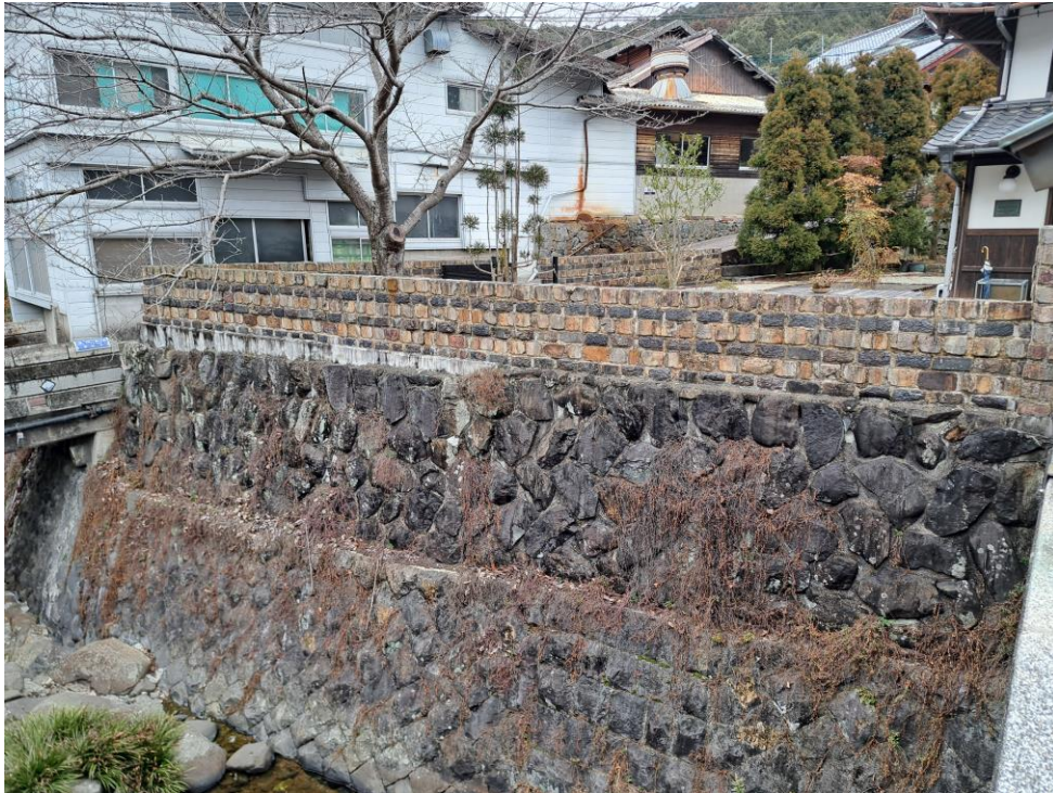
中尾郷内堀 トンバイを用いた塀
