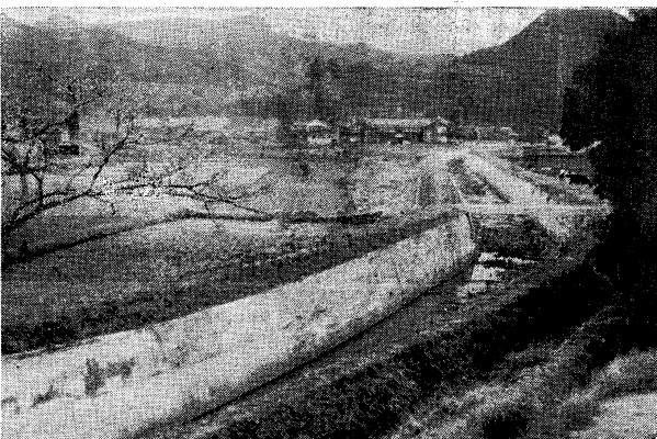
完成近い長野川河川工事
