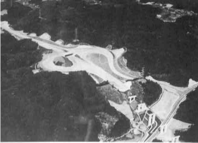
3月24日に開通する波佐見・有田インターチェンジ
