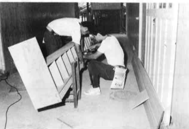
▲8月25日町内の大工さんが「一日労働奉仕」ということで中央小及び中学校の施設修理を行いました。この日は県建設産業労組波佐見支部会員(福田稔支部長ら7人)が築り早速床の修理や整理棚を新しく作るなど、持ち前の「技」を発揮しました。
