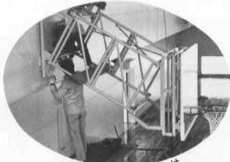
急ピッチで進む器具取付
