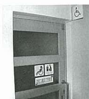
▲車椅子用トイレを多目的トイレに改修
