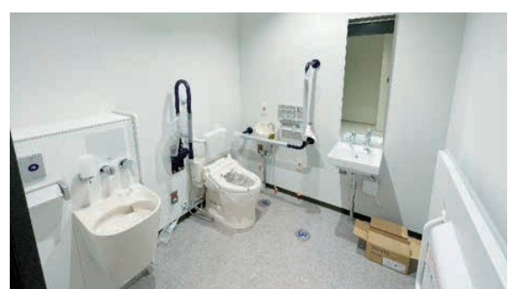
▲多目的トイレ
