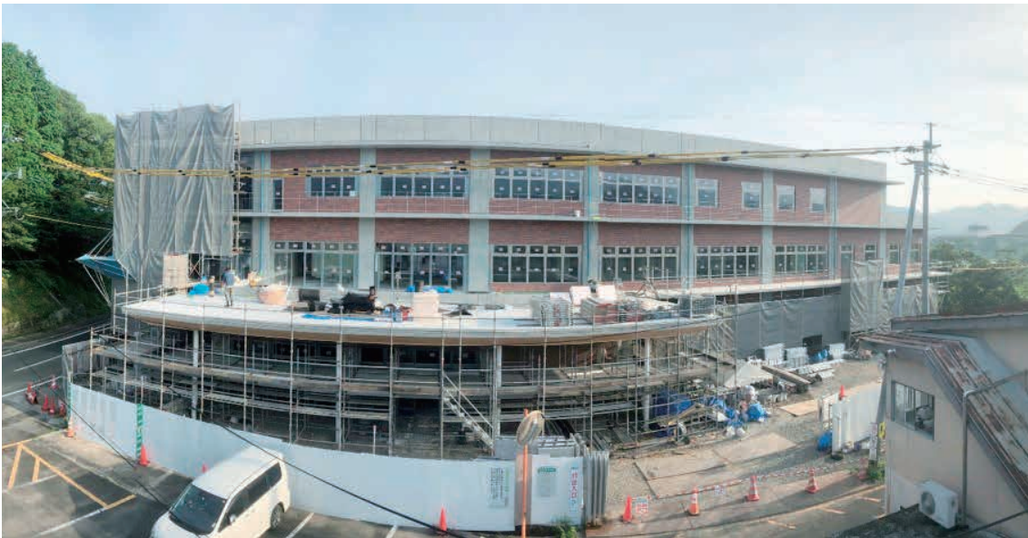
▲新庁舎全景（令和5年7月末現在の工事進捗率は約90%です）
