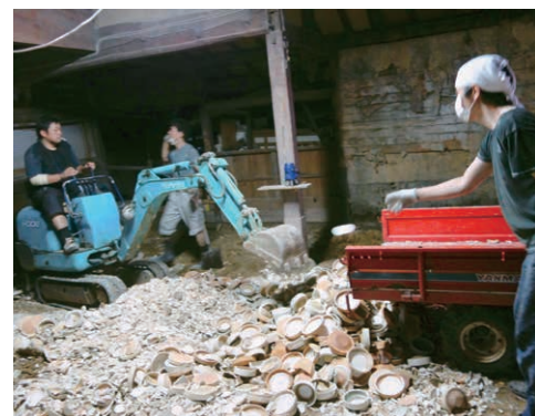
▲中尾郷に拠点を移し、重機を使って作業スペースを整えています。
