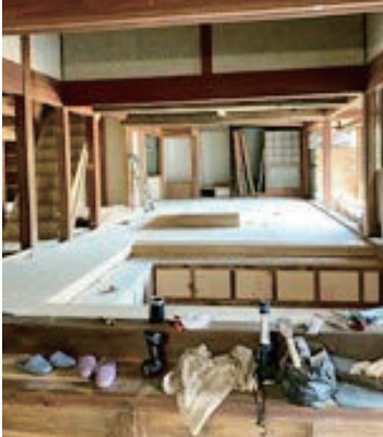
▲リビングに囲炉裏スペースを設置
