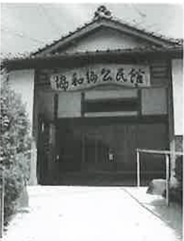
▲高齢者にやさしいスロープ完成
