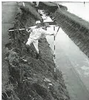
▲災害現場の測量
