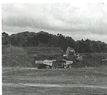
▲造成が進む工業団地
