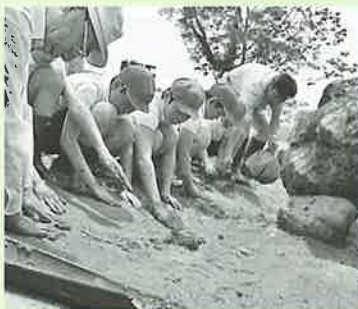
▲泥だんごを池全体に敷き詰める作業
