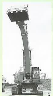
▲大迫力のパワーショベル
