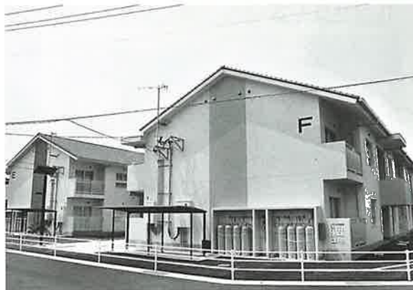
▲完成した山崎団地E・F棟
