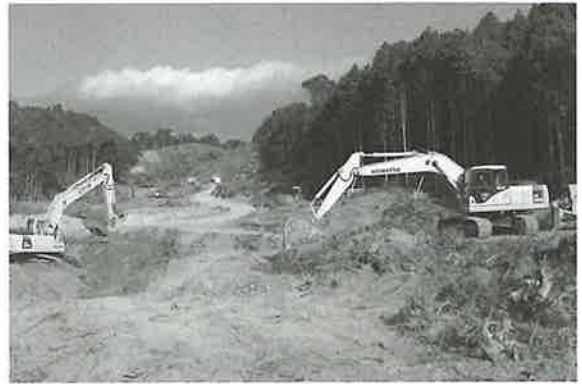
▲造成工事の状況
