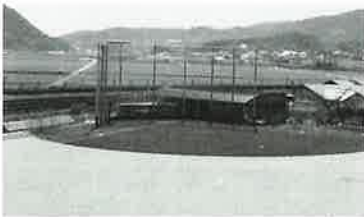
▲改修工事が完了したグラウンド
