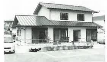
佐賀県介護実習普及センターバリアフリーモデル住宅
