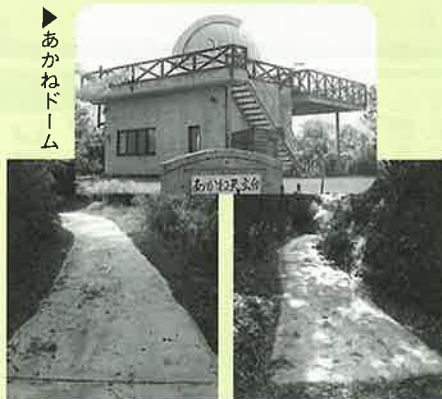
▲ボランティアで舗装されたあかねドームに通じる道路
