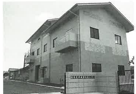
▲平成16年3月に運転を開始した「波佐見中央浄化センター」
