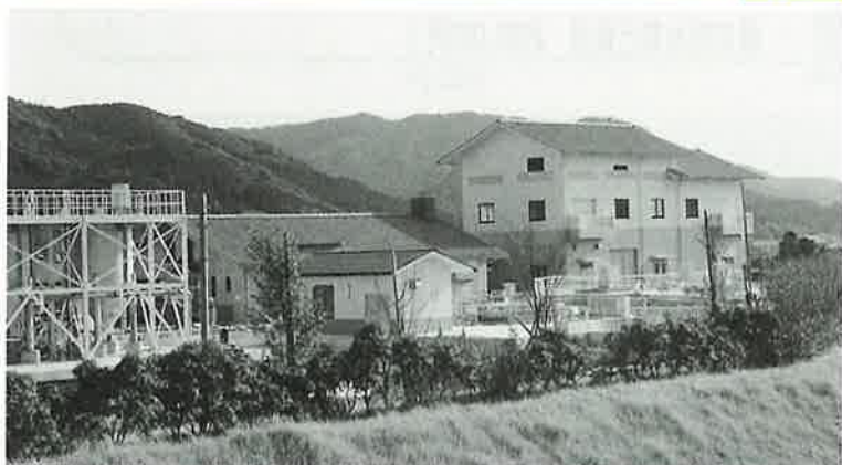
▲3月31日より運転を開始する「波佐見中央浄化センター」
