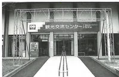
▲玄関には大きな看板とスロープ・手すりが設けられました
