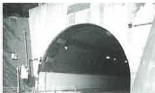
■（左）波佐見中央浄化センター用外装タイル（右）トンネル用高反射率タイル（施行例） 陶磁器クズなどを再利用した、地球にやさしいエコタイルです。（聖栄陶器）
