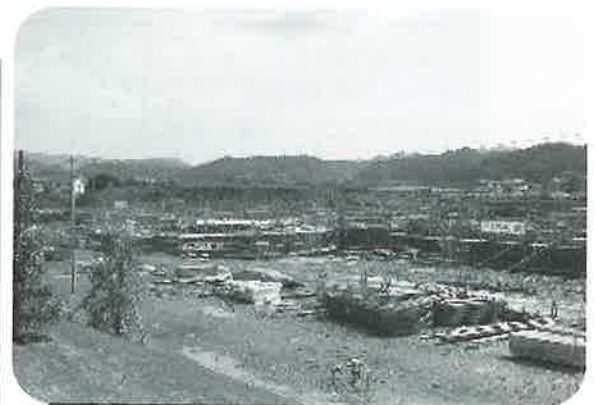
建設中の公共下水道終末処理場（宿郷）
