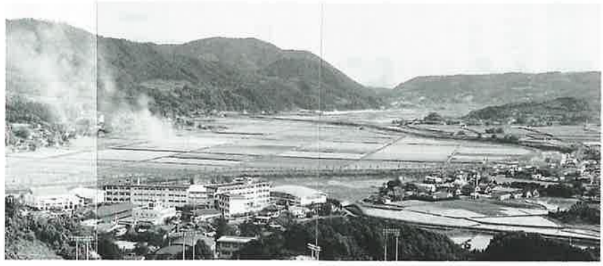
岳辺田地区の現況 （鴻ノ巣公園より撮影）
