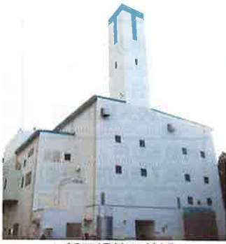
▲新工場棟の外観
