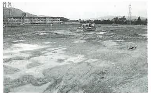
▲急ピッチで進められる造成工事
