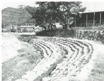
自然石を利用した河川工事
