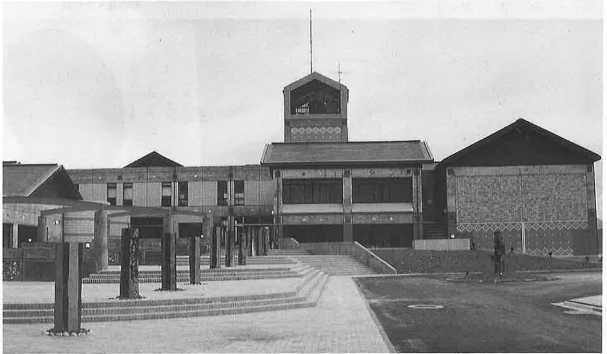
ほぼ完成した「長崎県窯業技術センター」 (3月4日撮影)
