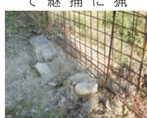
イノシシによる被害状況
