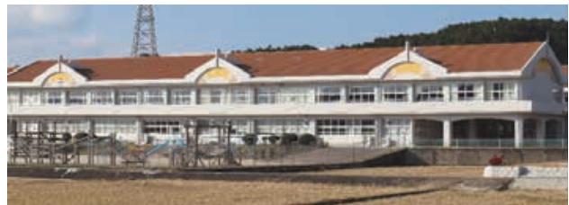
中央小学校校舎改修事業(外壁)
