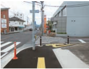
歩道の整備箇所
