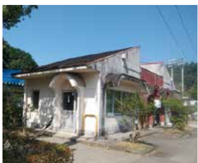
鴻ノ巣グラウンドの管理棟
