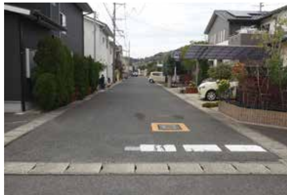
町道深添線に接する住宅団地内の道路
