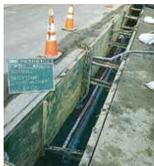
汚水管布設工事の様子
