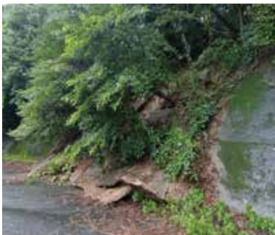
豪雨で通行止めの町道中居山線(井石郷)
