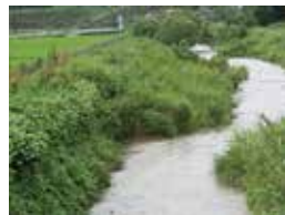
土羽状態の法面
