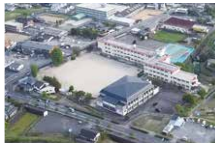
上空から見た東小学校周辺
