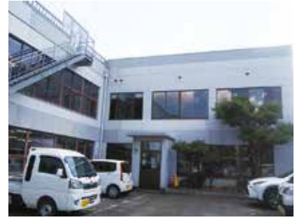
残存し利活用が期待される現庁舎新館
