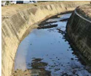
浚渫された皿山川(稗木場郷)
