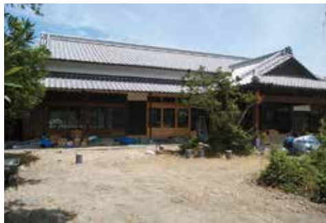
工事中の歴史文化交流館（仮称）
