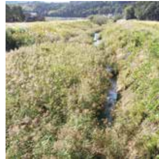
稗木場春田橋の状態
