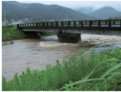
大雨で増水した河川
