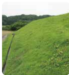
法面に植栽されたむかで芝
