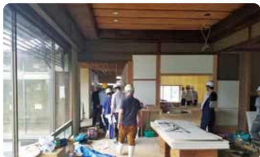
工事中の歴史文化交流館玄関ホール
