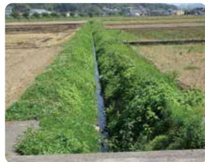
暗渠化が望まれる排水路
