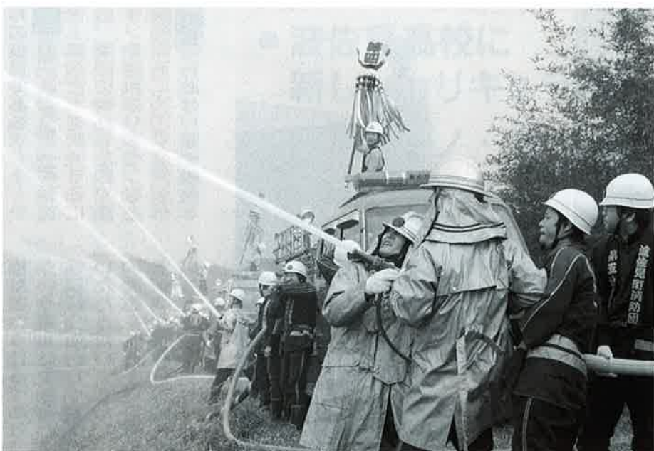
放水はじめー!
