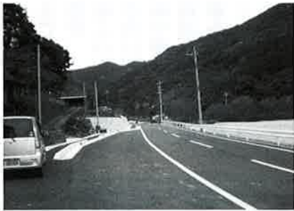
もうちょっとで完成ばい（町道川内本線）
