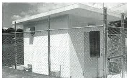
工業用水道「内ノ波水源ポンプ所」(折敷瀬郷)
