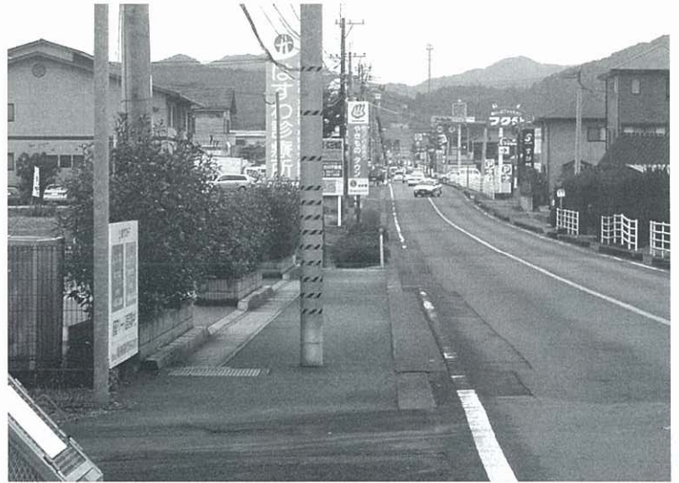
歩道の上にある危険物
