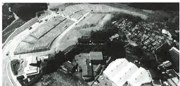
整備が急がれる西ノ原地区
