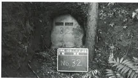
金山抗口閉塞工事
