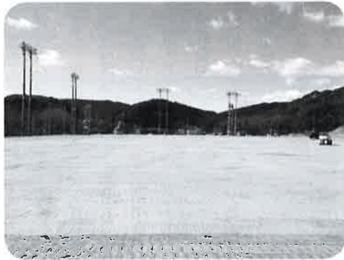
改良工事が進む鴻ノ巣公園グラウンド
