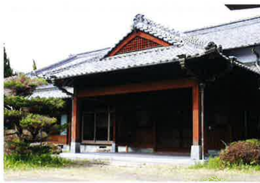
整備が予定されている古民家
