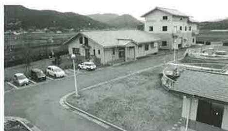
中央浄化センター
