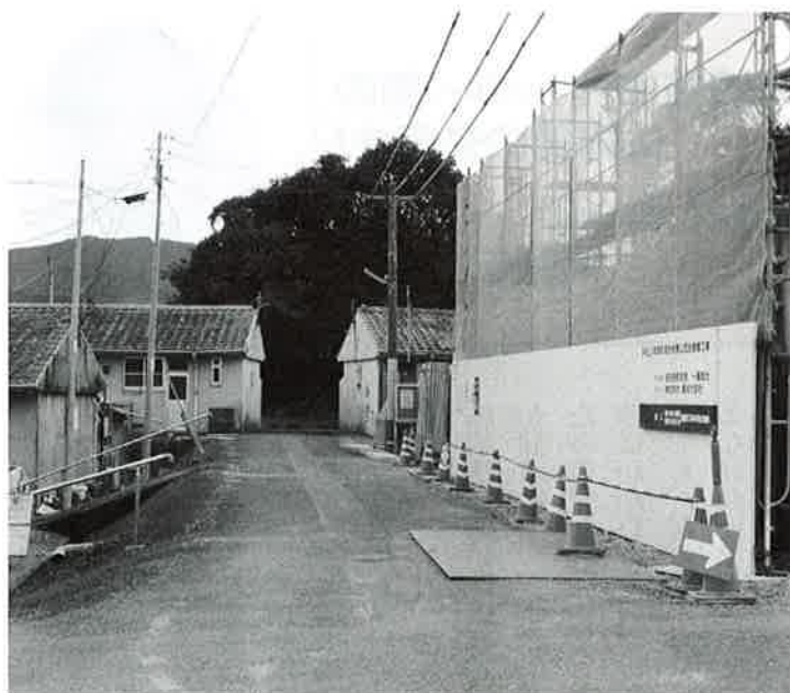
建設が始まった鹿山住宅
