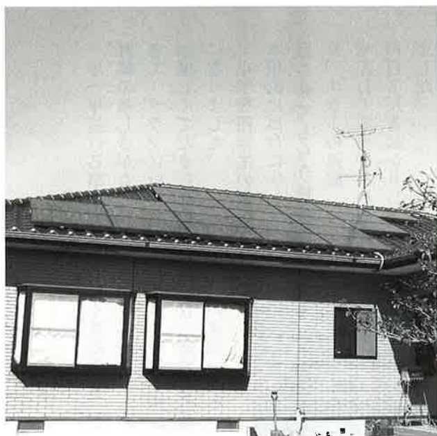
設置された太陽光パネル
