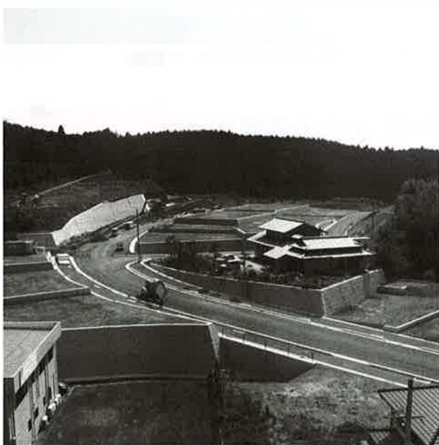
平成27年度完了予定の南側工区
