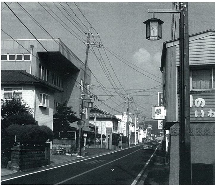
整備された街路灯 (西ノ原地区)
