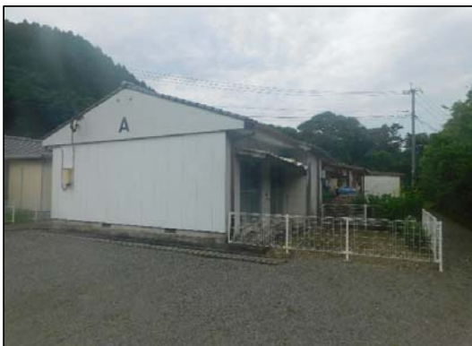
簡易耐火構造平屋建（庭側）
