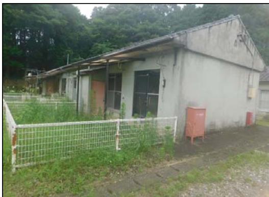
簡易耐火構造平屋建（庭側）
