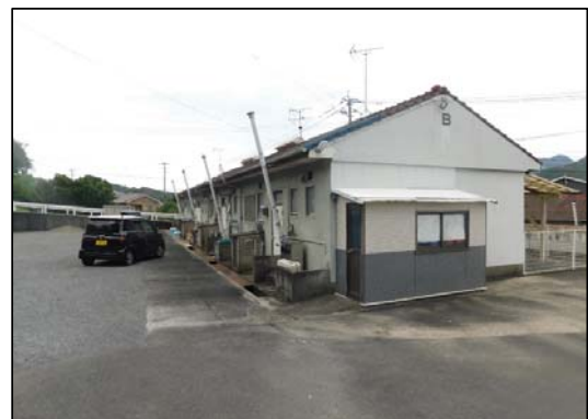
簡易耐火構造平屋建（玄関側）
