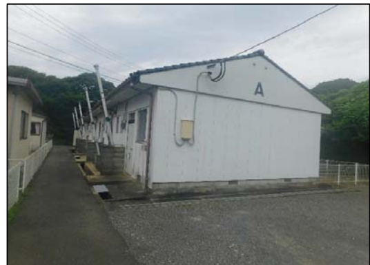
簡易耐火構造平屋建（玄関側）
