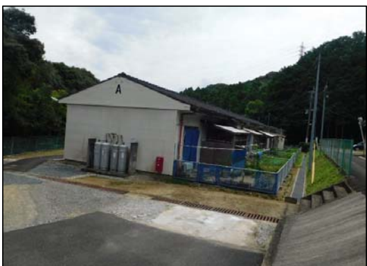
簡易耐火構造平屋建（庭側）
