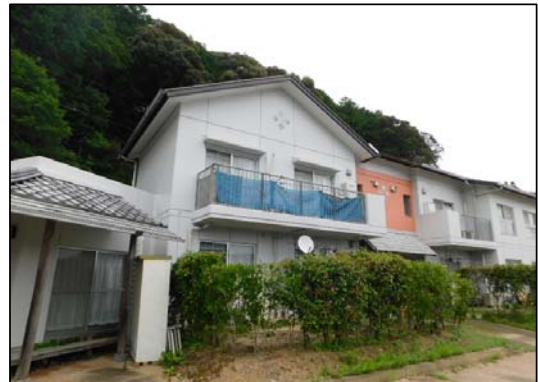
低層耐火構造二階建（1階玄関側）
