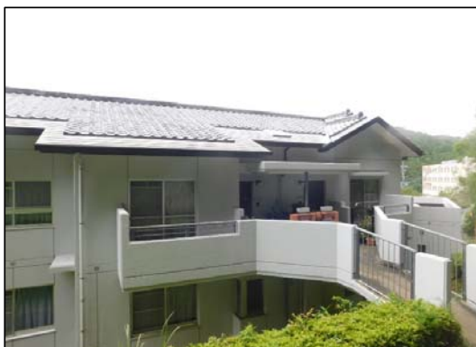
低層耐火構造二階建（2階玄関側）
