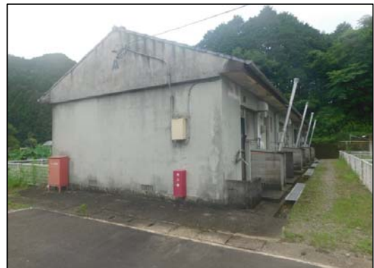
簡易耐火構造平屋建（玄関側）
