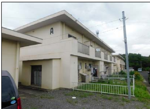
簡易耐火構造二階建（庭側）
