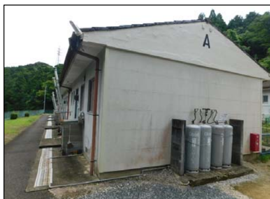
簡易耐火構造平屋建（玄関側）
