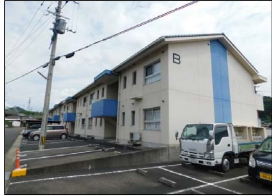
低層耐火構造二階建（玄関側）
