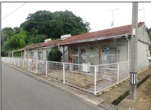
簡易耐火構造平屋建（庭側）
