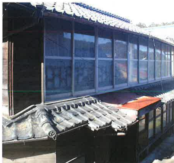
現在中尾郷にある空き家
