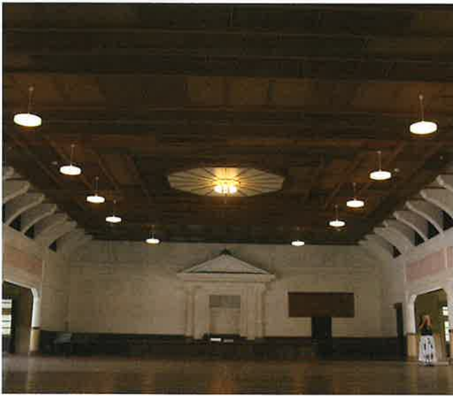
耐震整備された旧公会堂
