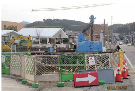
工事中の宿郷鹿山橋付近
