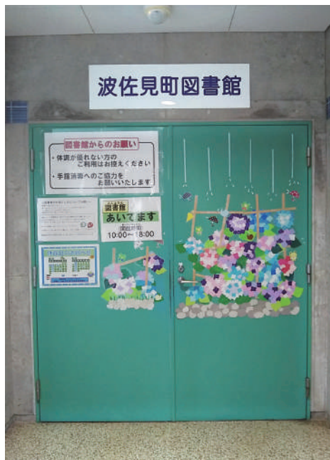
改修予定の図書館入り口扉
